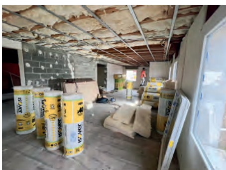
Février 2023 Rénovations de l'intérieur de l'ancien bâtiment
