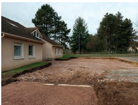
Mars 2022 Terrassement et pose de la cuve de récupération d'eau (10.000 litres)
