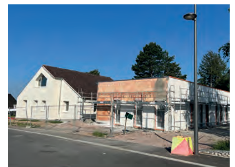
Mai-juin 2023 Enduit du nouveau bâtiment
