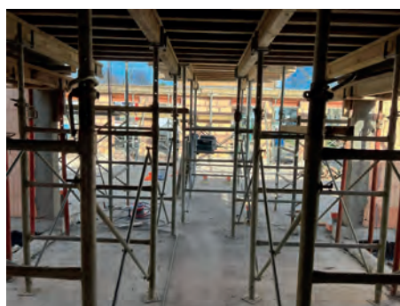
Octobre 2022 Ouverture dans le bâtiment existant
